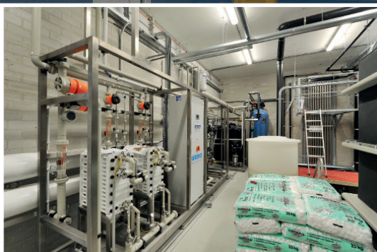
Die Package-unit-Bauweise ermöglicht eine schnelle Einbringung in das Gebäude
