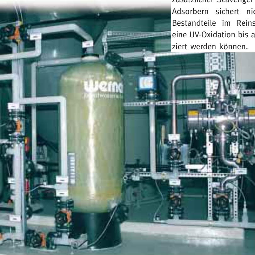
UV-Oxidation, Polisherstufe und 0,1 \mu m Membranfiltration (15.000 l/h)
