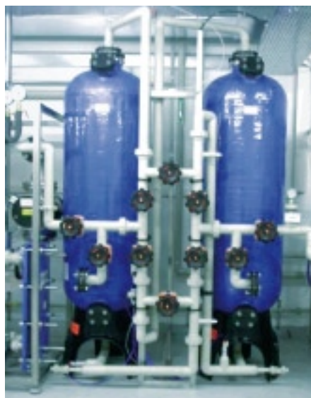
Polisher-System 12 m³/h, Mikroelektronikproduktion
