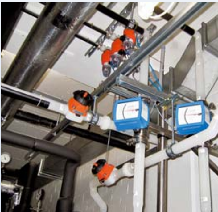
Details PVDF-Ringleitung mit Ausgleichschenkeln
