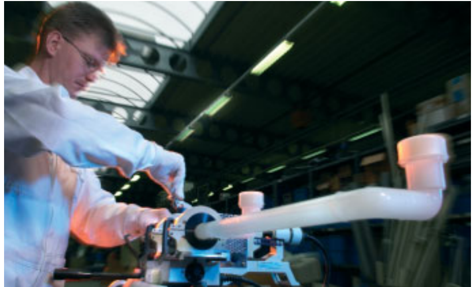
Abb. 3: Hochinerte Werkstoffe werden im IR-Schweißverfahren verarbeitet (Rohrstrang PVDF) zur Vorbereitung einer Ringleitung für hochreines Wasser.
